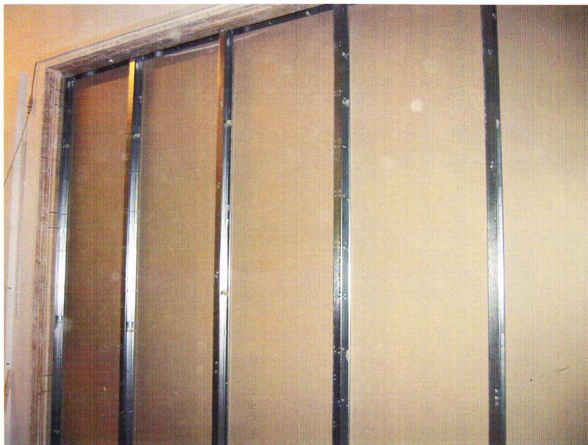
Seinä levytettynä vastaanottohuoneen puolelta ja metallirangat.
